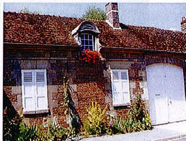
Les murs des maisons en brique et pierre sont appelés **murs composites** : il s'agit de murs de **blochage** avec parement de moellons coupés par des **cordons de brique** stabilisant la maçonnerie. Inversement, il y a aussi des **nervures de pierre de taille avec tapisserie en brique**. Ces parements nobles sont destinés à rester apparents.
