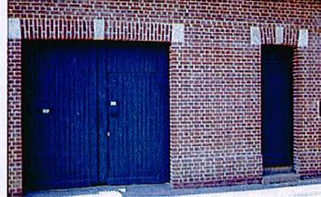
Ravalement de mur de brique, joints à la chaux avec un appareillage panerresse/boulisse, occultation par un store intégré
