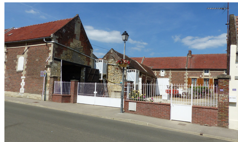
Siège d'exploitation agricole situé rue de l'Église.
